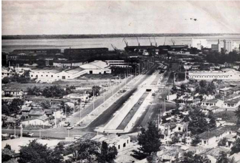
Figura 4 – Canalização da Doca de Souza Franco , década 70.
