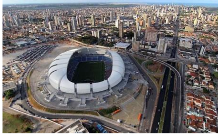
Figura 1: Viadutos em Natal e proximidade com área residencial.
